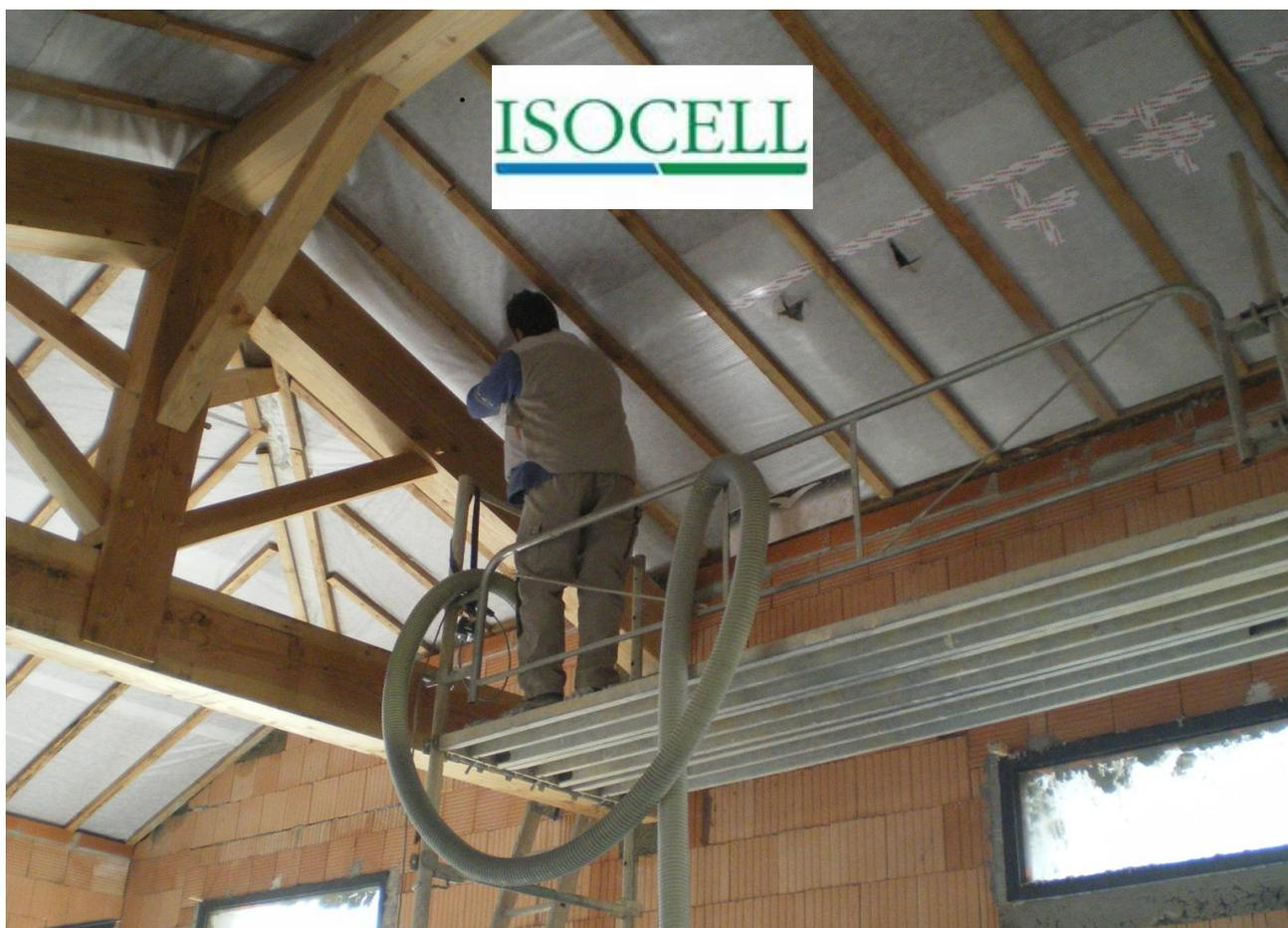
**ISOCELL est un isolant thermique en fibres cellulosique fabriqué à partir de papier journal grâce à un procédé de recyclage optimal.**
